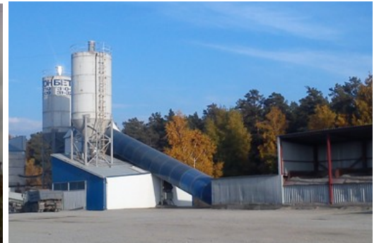
завод 120 м³/час в Барнауле
