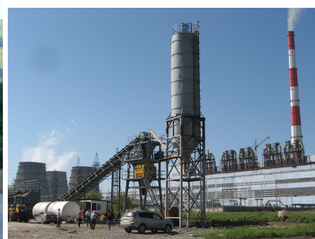
завод 60 м 3 /час в Барнауле
