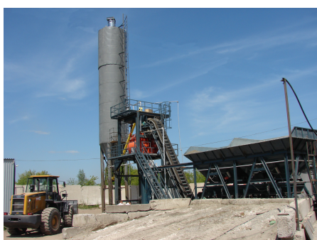
завод 60 м 3 /час в Барнауле
